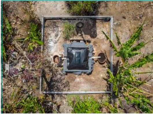
Sistema 6 Área Requerida: 7.8 x 4.0 m Biogás: 1.7 m 3 /día*
