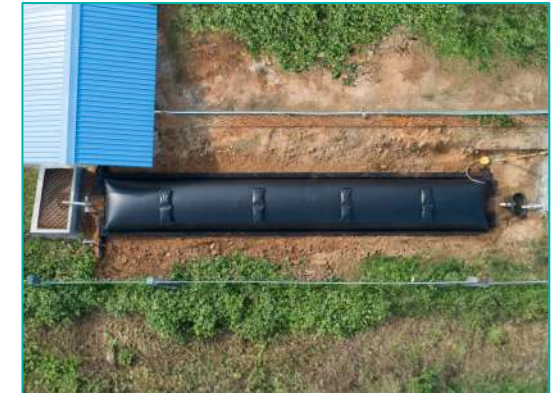
Sistema 40 Área Requerida: 23.0 x 7.0 m Biogás: 13 m 3 /día*
