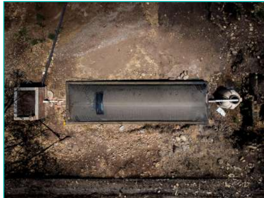
Sistema 20 Área Requerida: 15.0 x 4.0 m Biogás: 6.7 m 3 /día*
