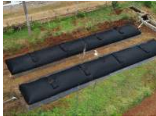
Sistema 80 Área Requerida: Sis 40 x 2 Biogás: 28 m 3 /día*
