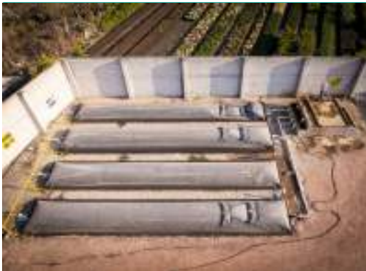
Sistema 160 Área Requerida: Sis 40 x 4 Biogás: 56 m 3 /día*
