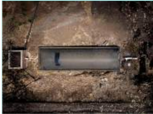
Sistema 20 Área Requerida: 3.4 X 12.2 m Biogás: 7 m 3 /día*
