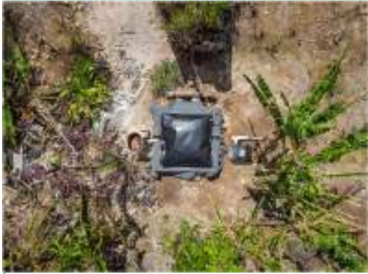
Sistema 6 Área Requerida: 3.4 X 5.4 m Biogás: 2 m 3 /día*
